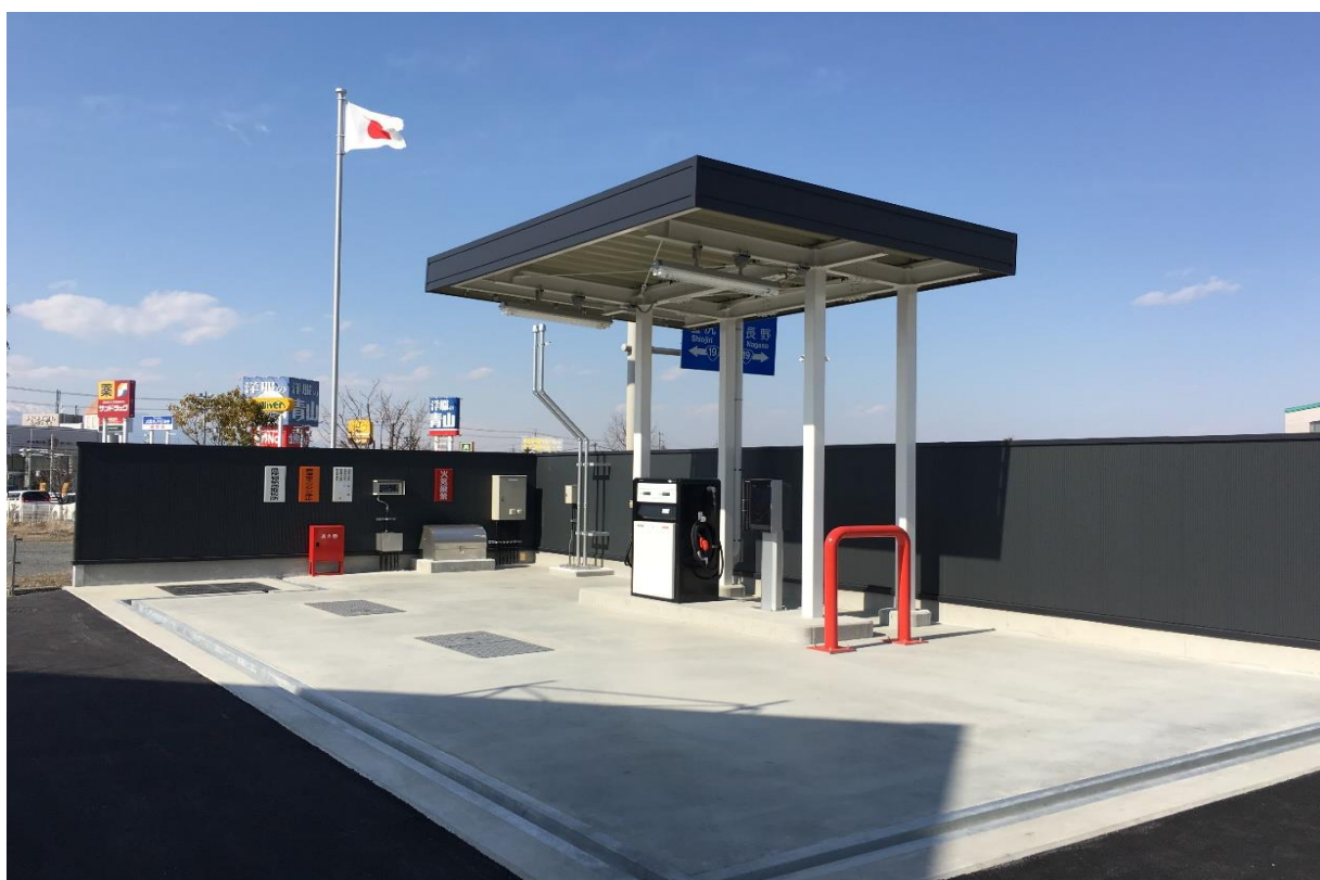
芳川消防署自家用給油取扱所設置工事竣工
