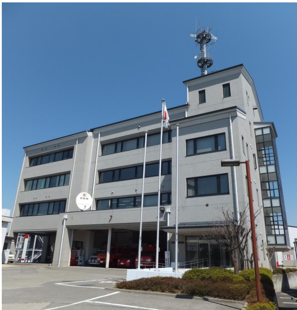
松本広域消防局庁舎
