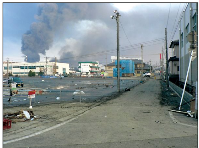
石油コンビナート火災の黒煙
